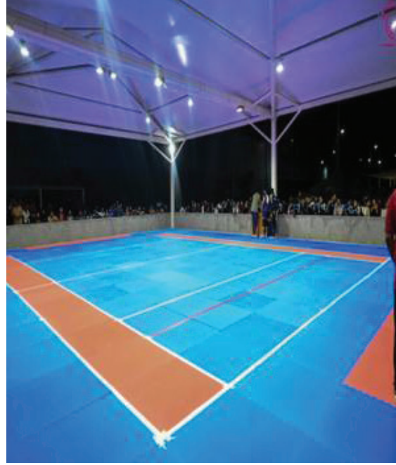
2 आउटडोर कबड्डी कोर्ट (उच्च गुणवत्ता वाली चटाइयों से सुसज्जित)
